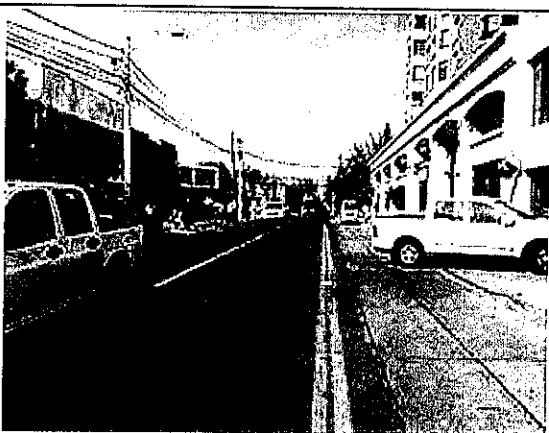
2.- Calle 1 Poniente hacia el sur
